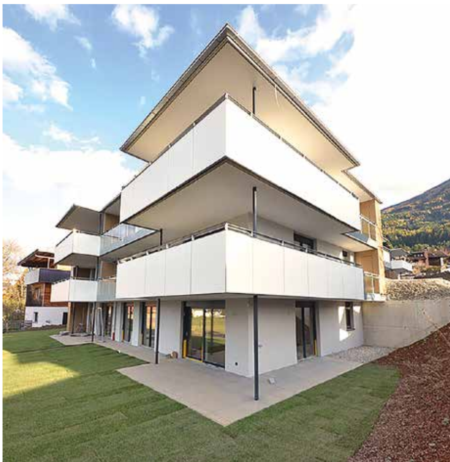
Auch im Innsbrucker Umland herrscht rege Bautätigkeit. Der Bauträger WAT errichtet beispielsweise in Sistrans das Projekt „Sissi“.
