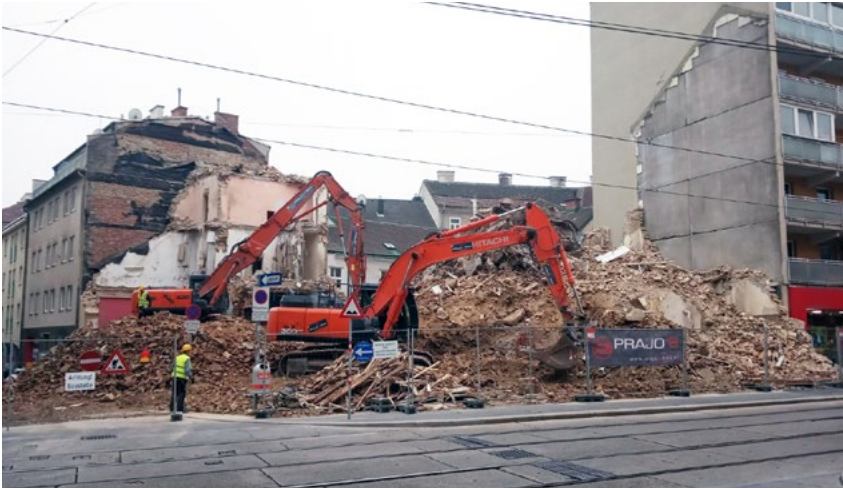
Abbrucharbeiten Lindauergasse 17, 1160 Wien
