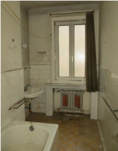
Badezimmer vor Sanierung
