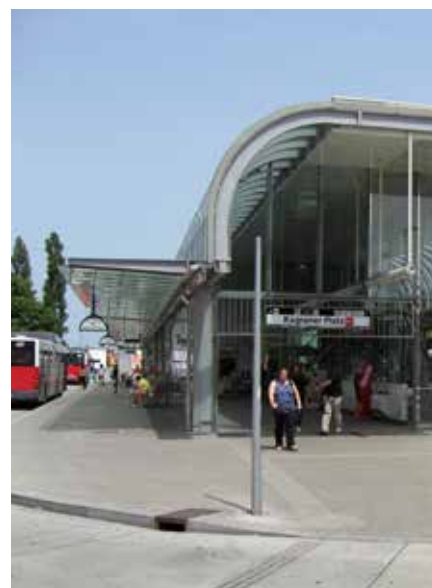
U-Bahn-Station Kagraner Platz
